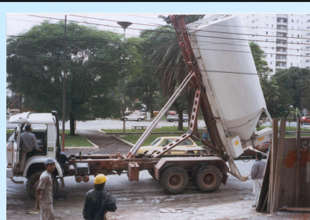
Argamassa entregue em silo
