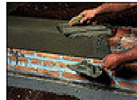
Além da argamassa com hidrofugante, a aplicação de emulsão asfáltica é essencial para o adequado desempenho em alicerces
