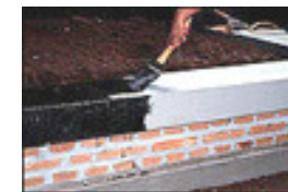
Além da argamassa com hidrofugante, a aplicação de emulsão asfáltica é essencial para o adequado desempenho em alicerces
