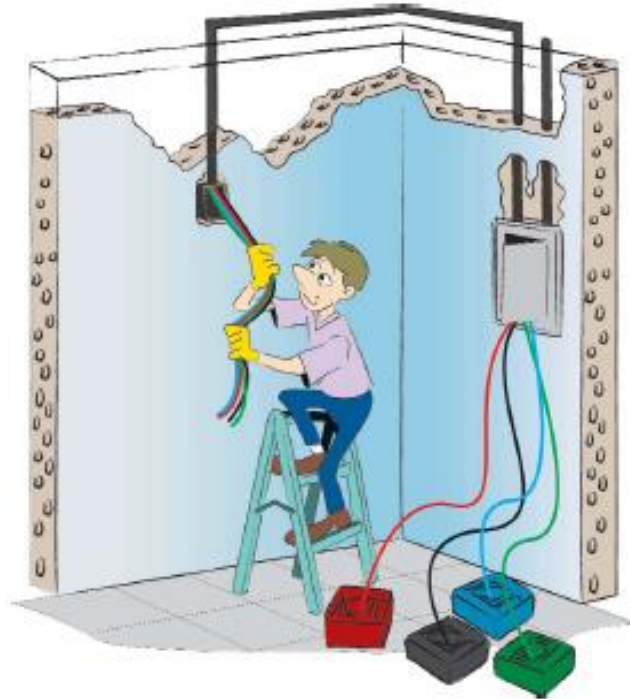
Figura 101 – Tracionando condutores.
