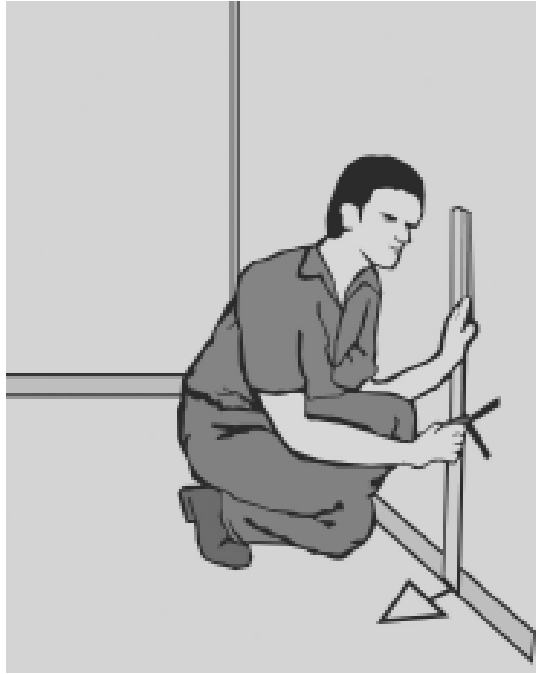
Figura 127 – Marcação do ponto de tomada na parede.
