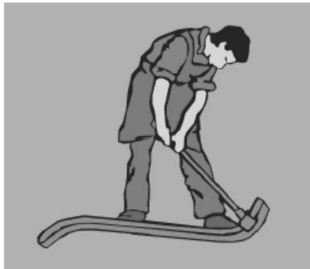
Figura 106 – Curvando o eletroduto.
