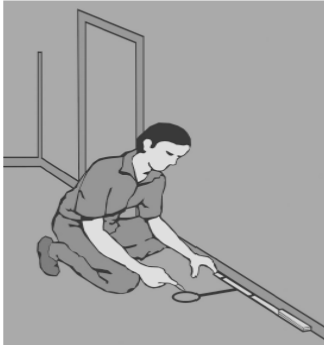
Figura 130 – Marcação da posição do interruptor no piso.
