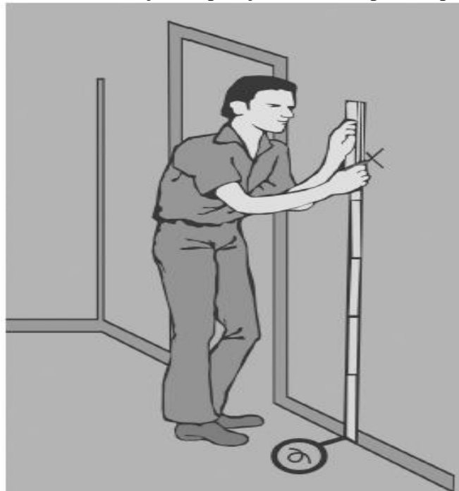
Figura 131 – Marcação da posição do interruptor na parede.
