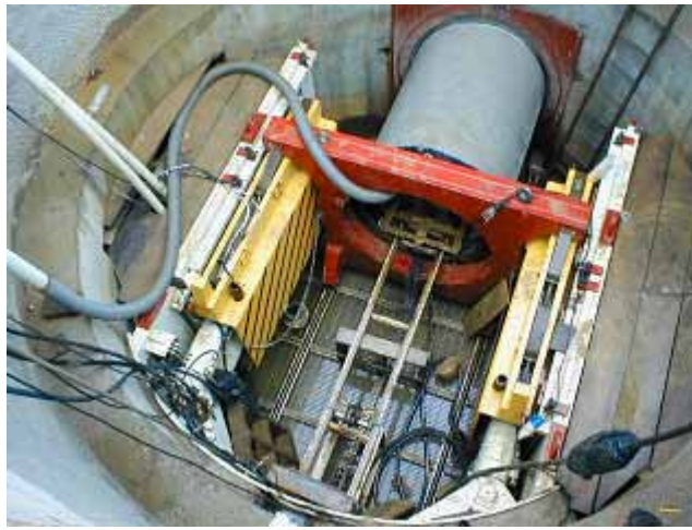
coletor-tronco (400 a 2000 mm de diâmetro) - fonte: Sabesp
