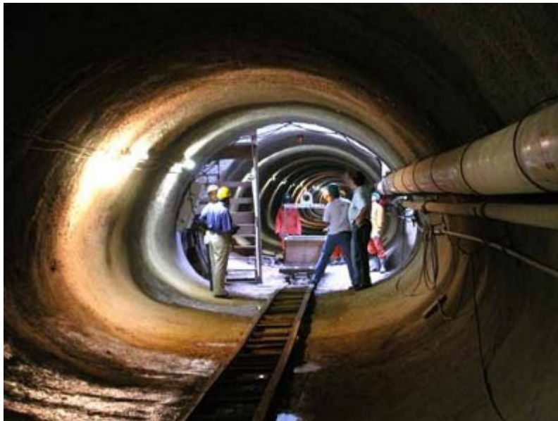
interceptor (1,5 a 4,5 metros de diâmetro) - fonte: Sabesp
