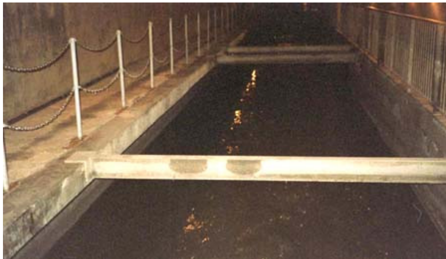
Foto dos esgotos de Paris - fonte: site de História das instalações de esgoto ( http://www.sewerhistory.org )
