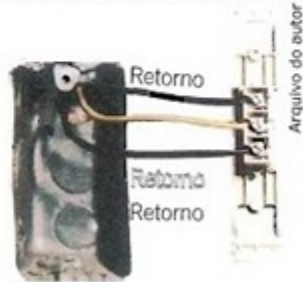
Instalação de interruptores paralelos em alvenaria.
