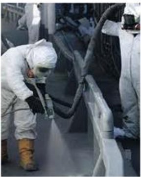
Jato de granalha
